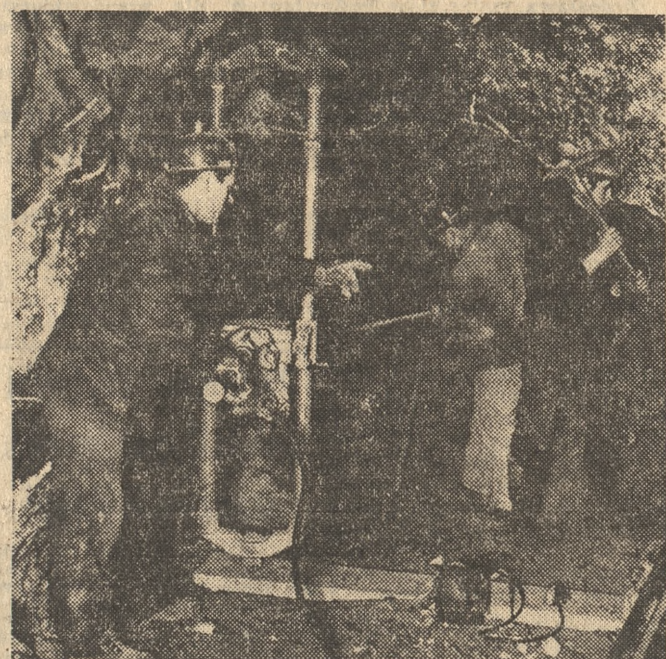
Kopalnia Soli w Wieliczce jest nie tylko najstarszym, ale i największym producentem soli warzelnianej w kraju, która trafia na nasze stoły. Poza tym wydobywa się tu także solanki dla potrzeb przemysłu chemicznego. Na zdjęciu: prace przy drążeniu nowego chodnika.
