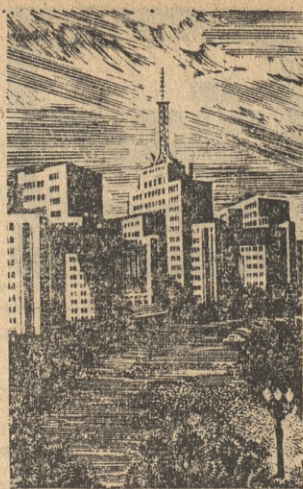
Charków — budownictwo wysokościowe.
