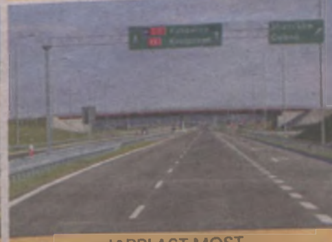
JARPLAST MOST Budowa obwodnicy Jarocina
