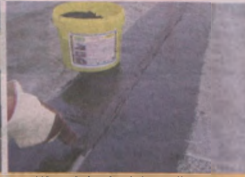
Wypełnianie dylatacji KITEM DEKARSKIM trwale plastycznym
