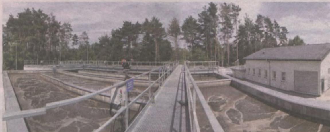
Oczyszczalnia ścieków w Boguszyńcu
