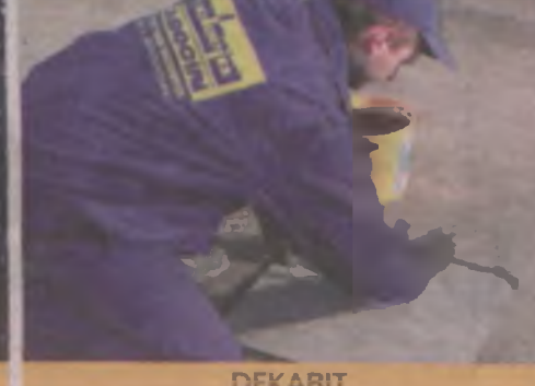
DEKABIT naprawa pękacza na dachu
