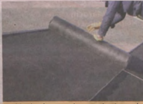
Układanie membrany dachowej AlfaBIT
