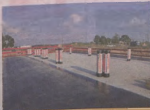
JARPLAST MOST Budowa obwodnicy Jarocina
