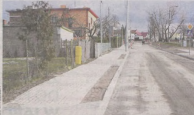
Na osiedlu Kopernika pozostaje jeszcze tylko ułożenie ostatniej warstwy ścieralnej na ulicach, wykonanie wyniesionych skrzyżowań z kostki brukowej oraz oznakowania poziomego. Efektem końcowym będzie zagospodarowanie terenów zielonych
