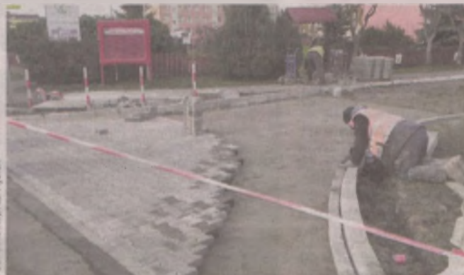
Z pieniędzy mieszkańców bloków wykonane zostały m.in. wjazdy na osiedle
