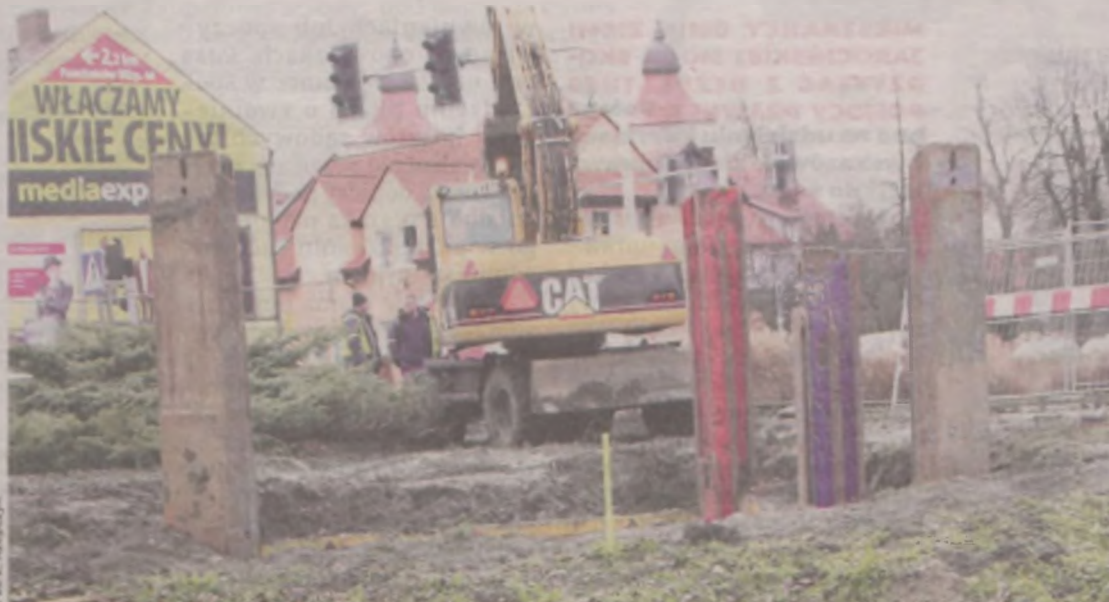
Prace przygotowawcze do rozpoczęcia wymiany sieci w centrum Jarocina trwają już na skwerze przy skrzyżowaniu ulic św. Ducha i Wojska Polskiego
