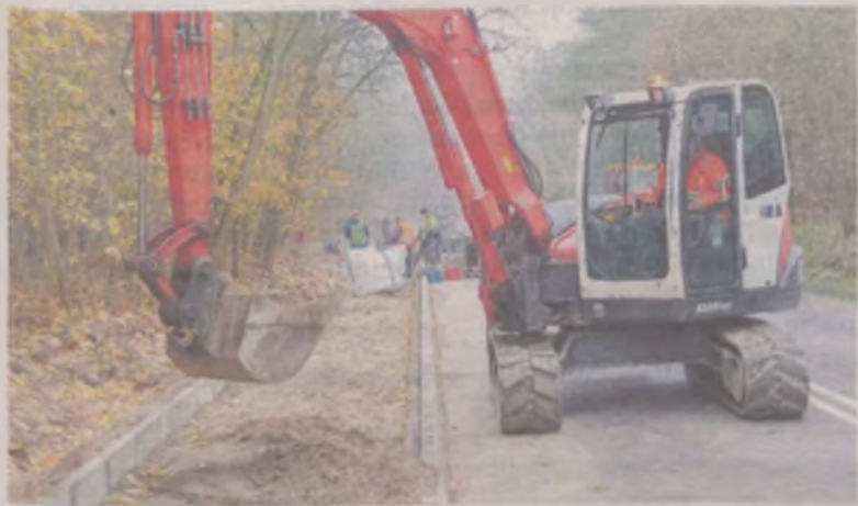
Budowa drugiego odcinka ścieżki rowerowej jest na ukończeniu
