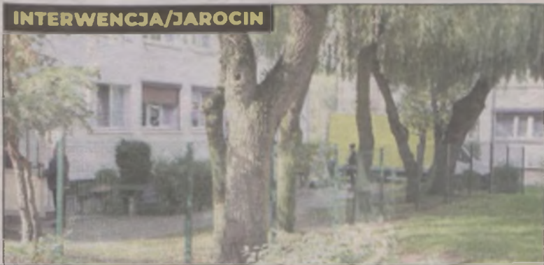
Ogrodzenie przed blokiem nr 4 na os. Konstytucji 3 Maja w Jarocinie ma zabezpieczać przed zjeżdżaniem ze skarp
