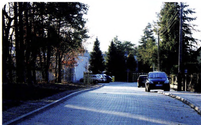
Budowa ul. Powstańców Wielkopolskich
