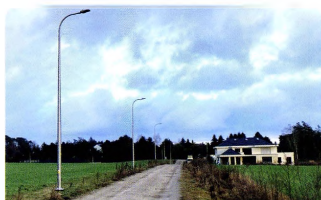
Budowa oświetlenia ulic: Łodowcowej, Myśliwskiej, Rumiankowej, Dąbrowskiego, Langego i bocznej od Gwarnej
