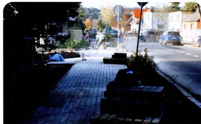
Budowa chodnika na ul. Dworcowej
