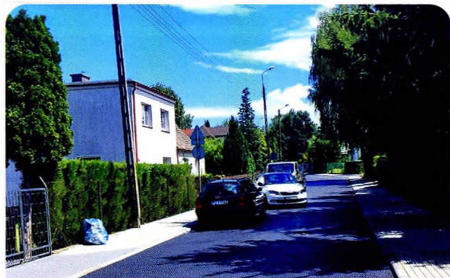
Budowa ul. Leśnej
