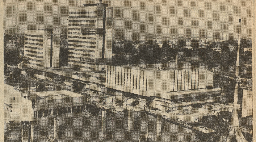
Fragment nowego centrum Kecskemet. Na pierwszym planie, po prawej — Dom Kultury, który ma być przekazany do użytku jeszcze w tym roku.
