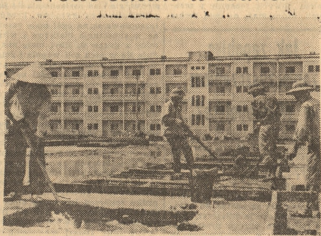
DRW. Budowa dużego osiedla mieszkaniowego „Giang Vo” w Hanoi.
