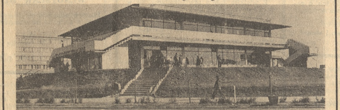
Wybudowany niedawno w Koninie dom handlowo-usługowy, o ciekawej architekturze cieszy się dużym powodzeniem wśród mieszkańców miasta. Fot. — K. Przychodźki
