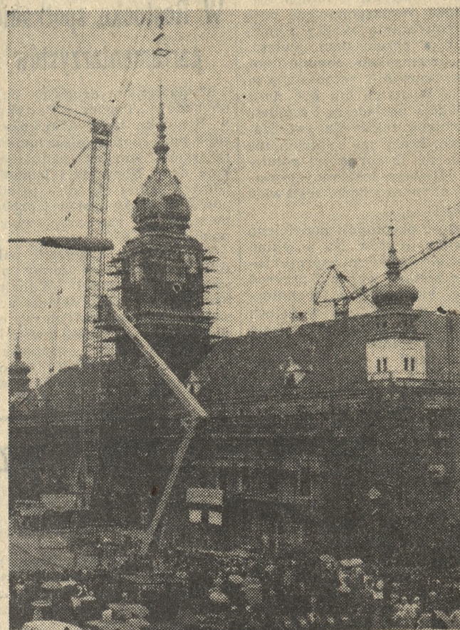
Kilka dni temu zakończono montaż kopuły Zamku Królewskiego w Warszawie. Na zdjęciu: mieszkańcy stolicy śledzą końcowe prace montażowe.
