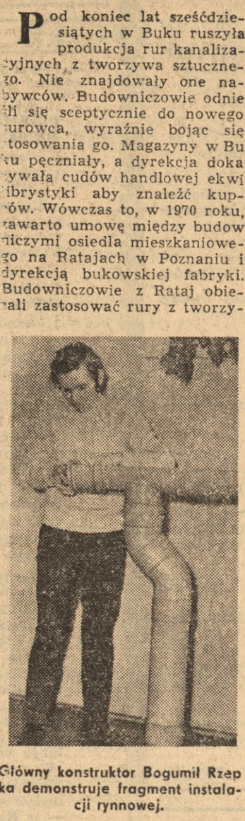
Główny konstruktor Bogumił Rzepka demonstruje fragment instalacji rynnowej.
