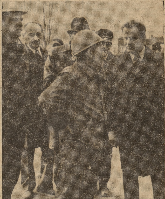
Na zdjęciu: I sekretarz KW PZPR — Jerzy Zasada na miejscu rozpoczęcia prac niwelacyjnych roznawia z Henrykiem Wlazłym, operatorem z Wielkopolskiego Przedsiębiorstwa Sprzętowego Budownictwa.
