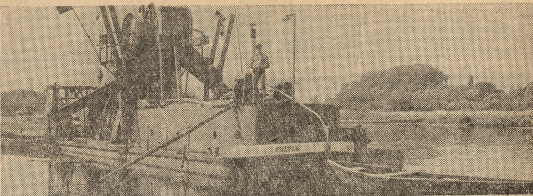
Fogiębiarka przy regulacji koryta Warty.
