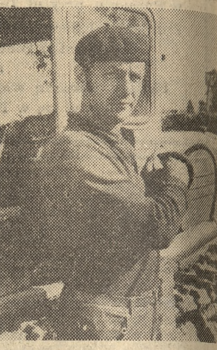
Na zdjęciu górnym: majster Władysław Kowalski (z lewej) i jego brat Zdzisław Wierczok i Zdzisław Sobczak przy budowie kanalizacji odwadniającej drogę. Na zdjęciu dolnym: Piotr Olejniczak przy swoim „Mazurze”.
