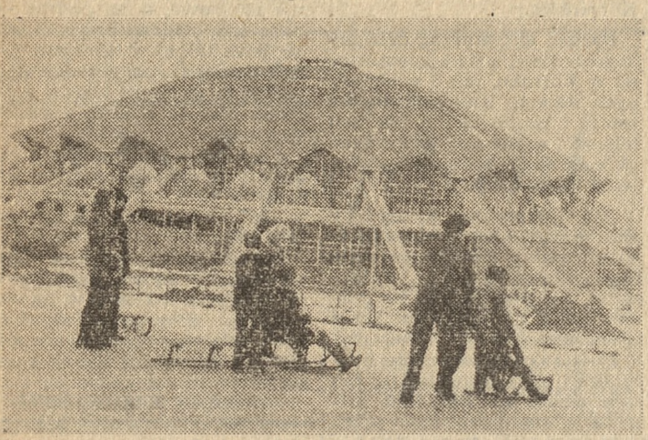
Hala sportowo-widowiskowa w pełnej okazałości, gotowa w sta- nie surowym.
