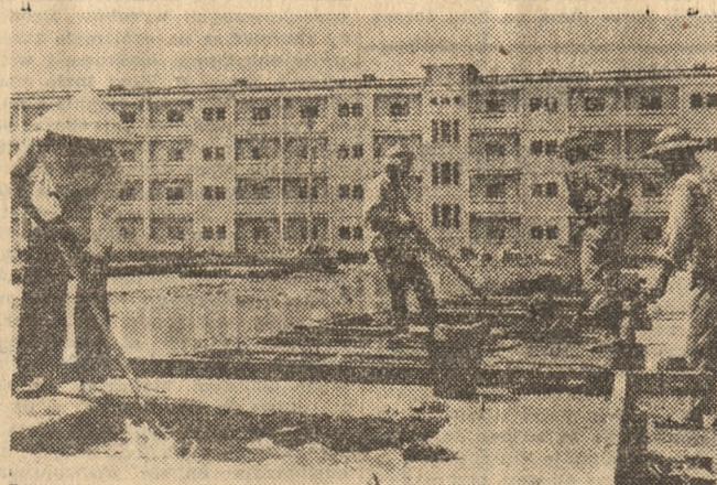
DRW. Budowa dużego osiedla mieszkaniowego „Giang Vo” w Hanoi.
