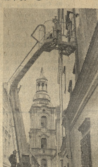
Przy pomocy samochodowego dźwigu — sprawnie było odnowić fasadę Pałacu Górków.
