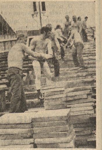
Pracownicy Spółdzielni Pracy Branży Skórzanej „Sportowa” pra- cowali w niedzielę przy porządko- waniu trybun stadionu. Fot. (2) — H. Kamza
