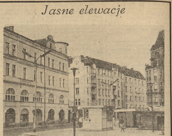
Wyjątkowo pod rok w naszym mieście pod względem odnawiania elewacji budynków. W I półroczu nową szatę otrzymało 370 obiektów. Kolorowe tynki na pewno przyczyniają się do upiększania ulic. Prace nadal są kontynuowane. Do Centralnych Dożynków sporo jeszcze domów zmieni swój zewnętrzny wygląd. Na zdjęciu: ładnie prezentują się — po odnowieniu — domy przy ul. Wodnej. Fot. — K. Przychodzki
