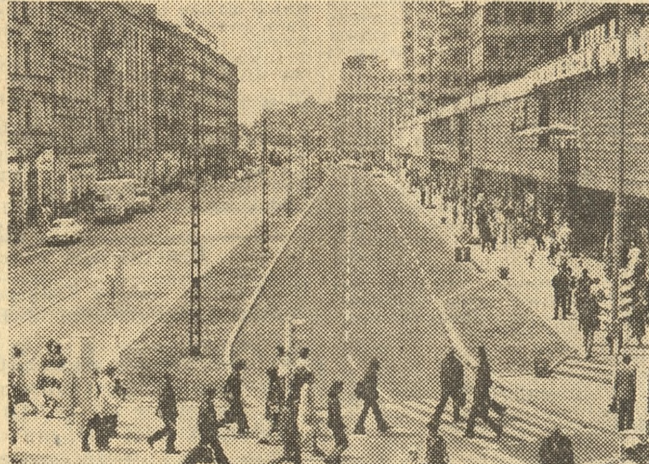
Zmodernizowanie odcinka ulicy Czerwonej Armii od ulic Ratajczaka do Lampego, poprawiło w pewnym stopniu poruszanie się samochodów w rejonie śródmieścia. Na zdjęciu: nowy odcinek jezdni ulicy Czerwonej Armii. Fot. — H. Kanza
