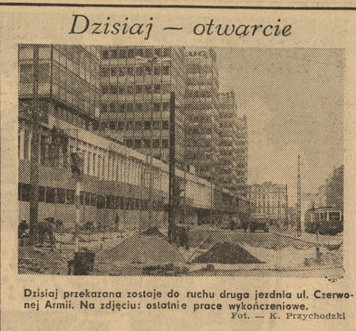
Dzisiaj przekazana zostaje do ruchu druga jezdnia ul. Czerwo- nej Armii. Na zdjęciu: ostatnie prace wykończeniowe. Fot. — K. Przychodźki
