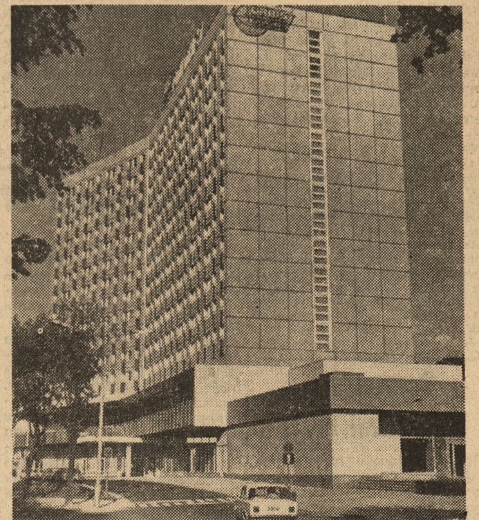
Po 15 miesiącach budowy stanął w Poznaniu nowy orbisowski hotel „Polonez”. Przy al. Stalingradzkiej wyrosła efektowna bryła 14-kondygnacyjnego budynku.
