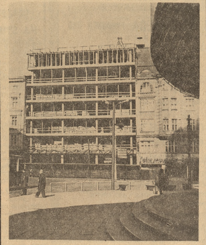
Nowy Dom Książki przy ul. Lampego (w miejscu dawnego Domu Dziecka) — już pod dachem. Fot. — K. Przychodzki
