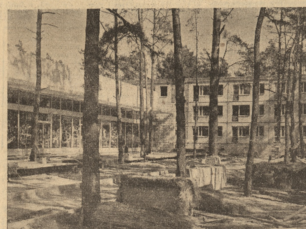
49 kilometrów za Poznaniem, jadąc nowo wybudowanym odcinkiem trasy E-8 w kierunku Wrześni, wylaniają się zza drzew kontury jasnych budynków. To hotel w Podstolicach z częścią gastronomiczną w ostatniej fazie budowy.
