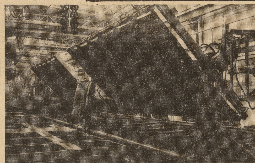
Fragment linii prefabrykacji ścian wagonów metalowych w zielonogórskim „Zastalu”. Fot. — „Głos”
