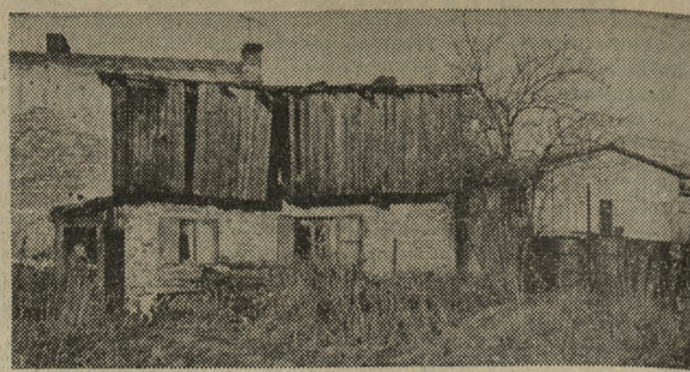
Fatrząc na to zdjęcie, trudno uwierzyć, że taka buda znajduje się przy jednej z głównych arterii miasta — ulicy Obornickiej. Aż dziw, że silniejszy podmuch wiatru dotychczas jej nie zniszczył. Swoją brzydota raz tym bardziej, że stoi tu obok ładnie utrzymanej Stacji Obsługi Samochodów — Automobilklubu Wielkopolski (ul. Obornicka 17). W dodatku nie opodal szopy znajduje się dzięki wysypisko śmieci.
