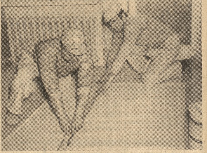
Naklejanie wykładzin łazienkowych — sprawa niby prosta. Zanim jednak przystąpi się do tego, trzeba według rozmiarów przyściąć wykładzinę. Tutaj każdy miłimetr gra rolę. Pamiętają o tym Stanisław Serba (z lewej), bytygadzi i Jan Ciesielczyk, również malarz-tapeciarz z Poznańskiego Przedsiębiorstwa Budowlanego nr 3 — generalnego wykonawcy „Poloneza”.
