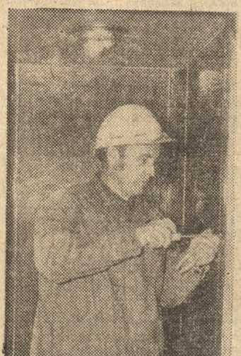
Wieloletni pracownik poznańskiego Zakładu Urządzeń Dźwigowych Łrygadziata — Józef Kuźnicki przy montowaniu kolejnej windy oso- bowej. Fot. (2) — K. Przychodźki
