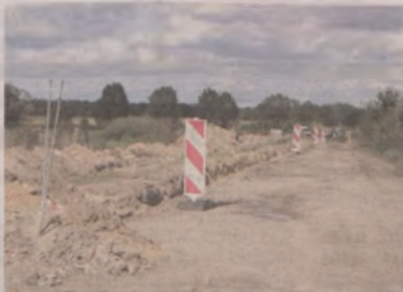
Pierwszy etap budowy łącznika ulicy Maratońskiej w Jarocinie z drogą Wilkowyja - Cielcza ma się zakończyć 31 października
