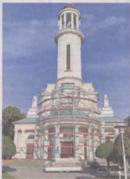
Prace przy kościele mają zostać przeprowadzone w tym roku. Wtedy też dopiero gmina prześle dofinansowanie, z którego parafia będzie musiała się rozliczyć
