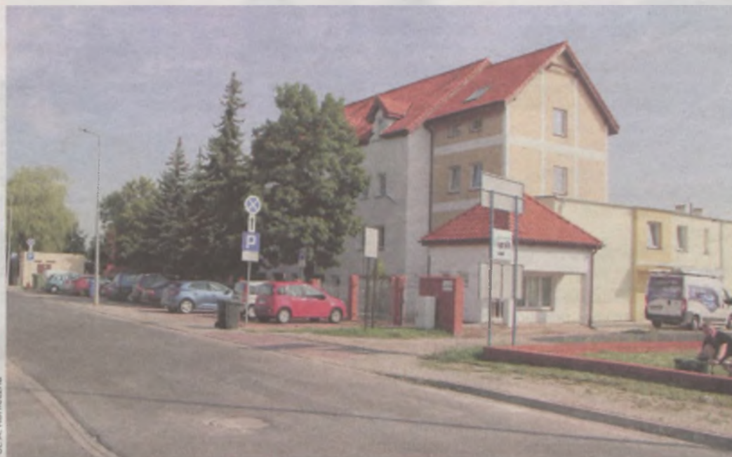
Wykonawcą rozbudowy obiektu z mieszkaniami chronionymi była firma Hadrzyński z Kotłina. Nowy, dwukondygnacyjny budynek ma ok. 600 m 2 powierzchni
