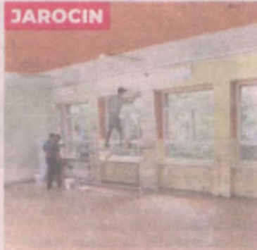
Prace remontowe w stołówce trwają już między innymi w Witaszyczach
