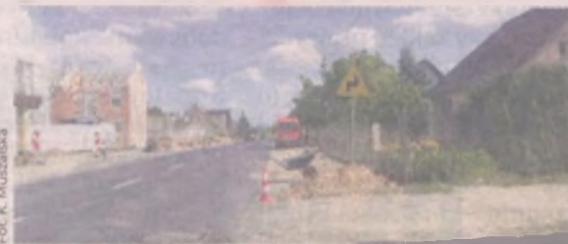
Po tym, jak niedawno budowana była kanalizacja, Annapol znowu jest rozkopany. Tym razem do posesji mieszkańców podłączany jest światłowód
