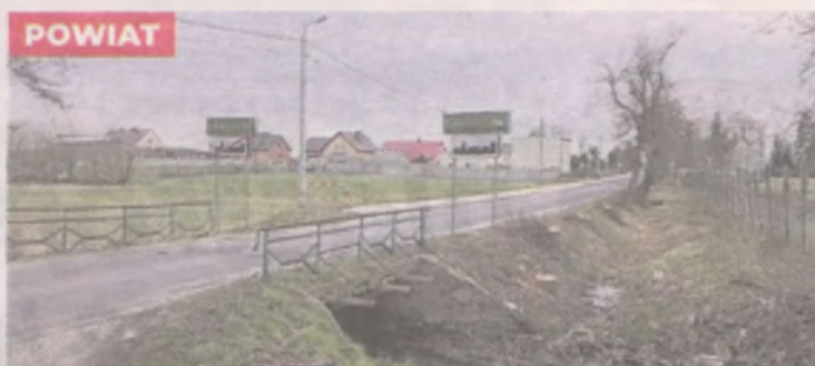
Jeszcze w tym roku most w Cerekwicy zostanie przebudowany
