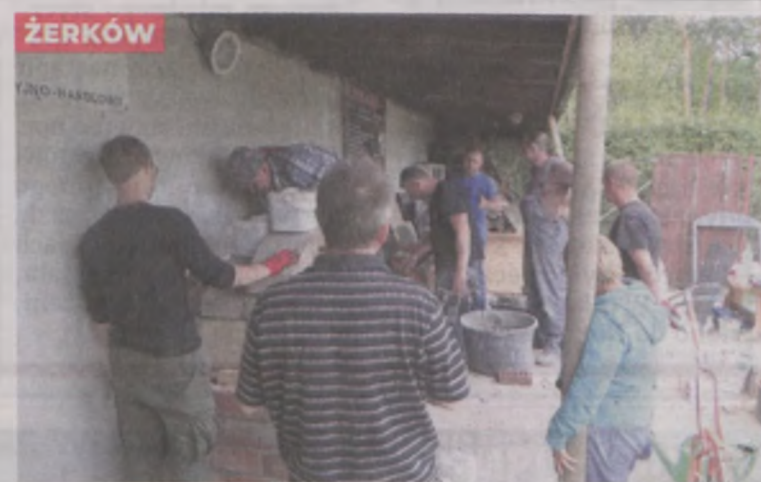
Uczestnicy warsztatów w czasie budowy pieca chlebowego i wędzarni
