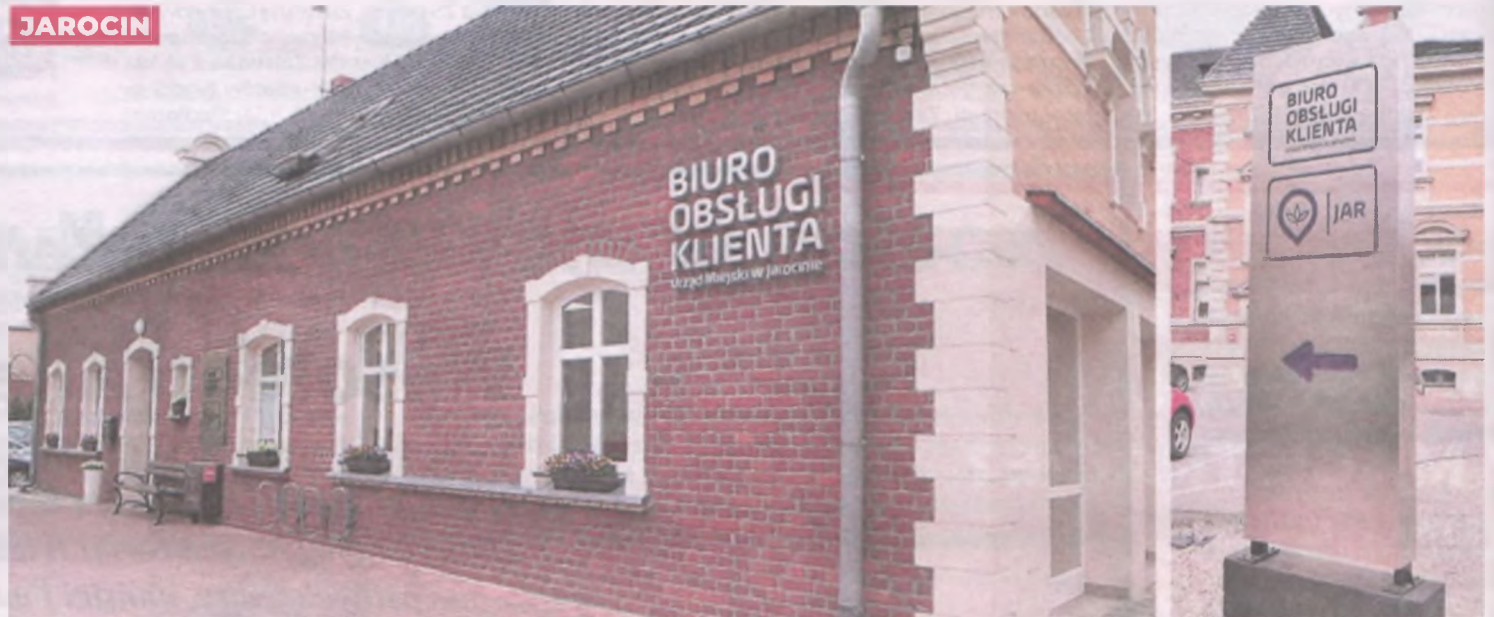
Biuro obsługi klienta urzędu miejskiego zlokalizowane w budynku Jarocińskiej Agencji Rozwoju oraz droga do niego zostały dobrze oznakowane
