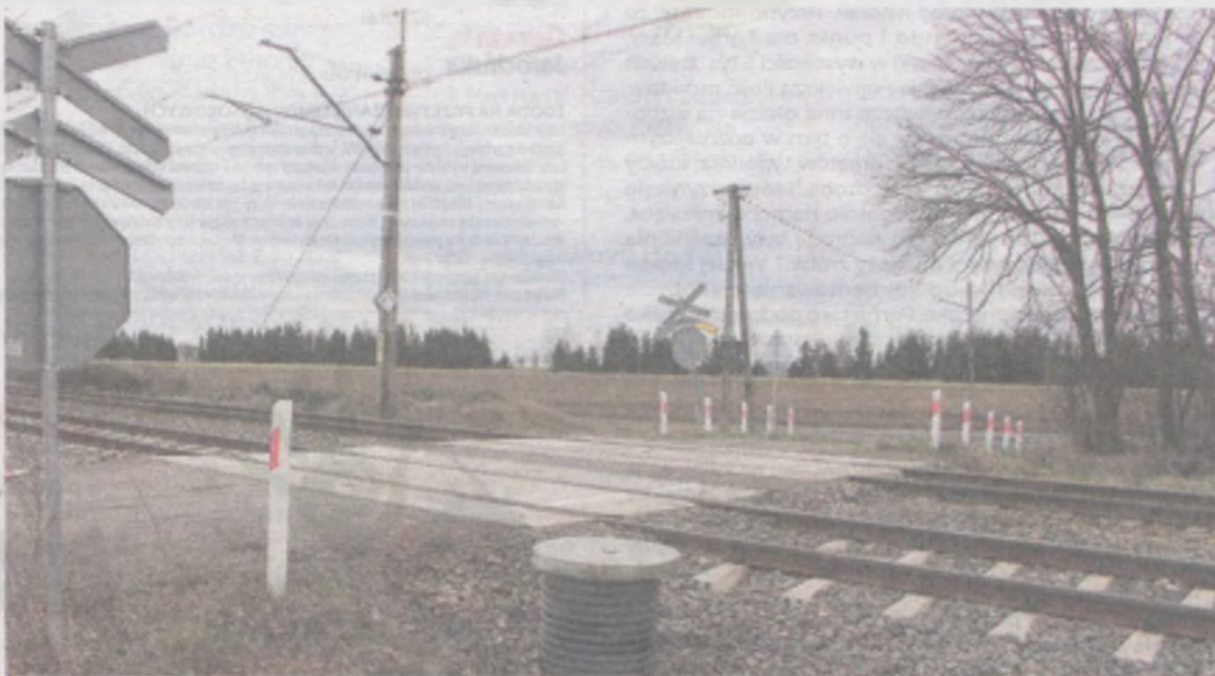
Przejazd kolejowy w Chrzanie przy ulicy Sportowej
