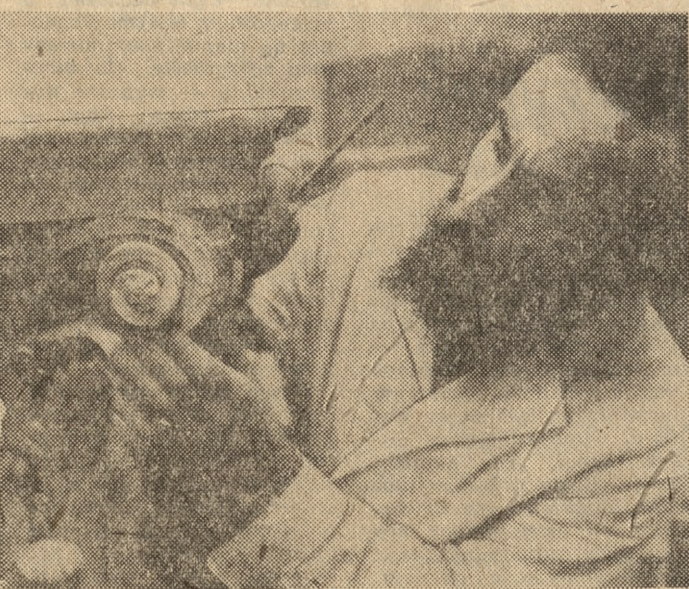
Na zdjęciu: konserwator Henryk Tomoń uzupełnia zniszczone detale głów wieńczących dawniej kolumny w kaplicy Zamku Królewskiego w Warszawie. Fot. — CAF
