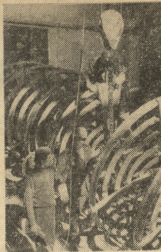
Pracownicy Mostostalu Wrocław przy montażu 22-metrowego dyfuzora.
