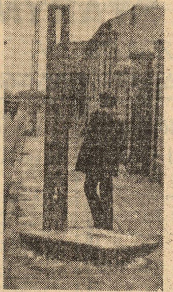
Płyty — zawalidrogi na ul. Poznańskiej czekają na wywiezienie. Fot. (3) — H. Kamza
