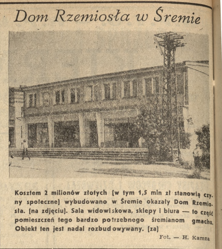
Koszt 2 milionów złotych (w tym 1,5 mln zł stanowią czy- ny społeczne) wybudowano w Śremie okazały Dom Rzemio- sła. (na zdjęciu). Sala widowiskowa, sklepy i biura — to część pomieszczeń tego bardzo potrzebnego śremlanom gmachu. Obiekt ten jest nadal rozbudowywany. (za)
