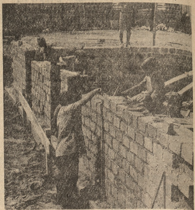
Na budowie hotelu dla junaków OHP w Gnieźnie — Skierszowie odbywała praktykę zawodową 22 uczniów Technikum Budowlanego nr 1 z Poznania. Obiekt ten będzie miał 108 miejsc oraz stołówkę i świetlicę. W opinii majstrów, pod których okiem chłopcy odbywali praktykę, młodzi adepci budowlanego fachu spisałi się bardzo dobrze i zasłużyli na pochwałę. Chyba przyszli lokatorzy hotelu nie będą zatem narzekać na usterki. (p-cz)
