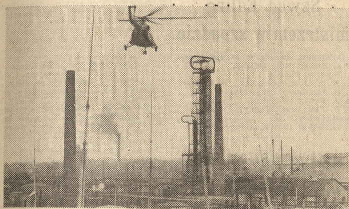
Śmigłowiec nad rafinerią ropnaftowej Czechowice-Dziedzice. Dzięki użyciu śmigłowca do montażu 150 iglic odgromowych, zakład zaoszczędził 20 milionów zł.
