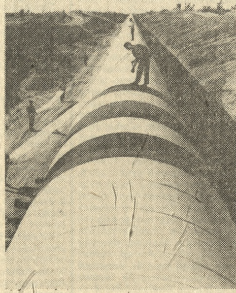
Realizacja planów nawodnienia dużych obszarów Rumunii, niezależna w dużym stopniu rolnictwo tego kraju od kapryśnych pogody. Na zdjęciu: montaż rurociągu, którym popłynie woda z Dunaju.
