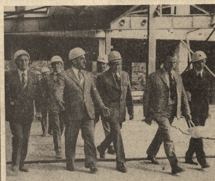
Na budowie „Poloneza”... Fot. — K. Przychodzki
