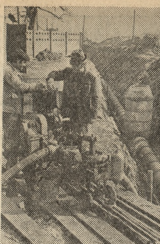
Pracownicy WPRW-K przy pomie odwadniającej odcinek wykopu, w którym układany jest kolektor.
