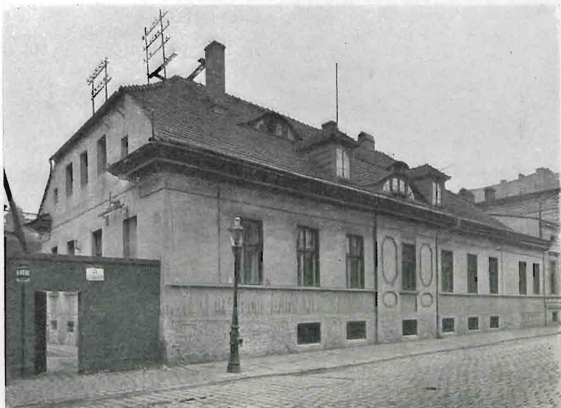
Ryc. 27. Budynek administracyjny przy Grobli 10.
