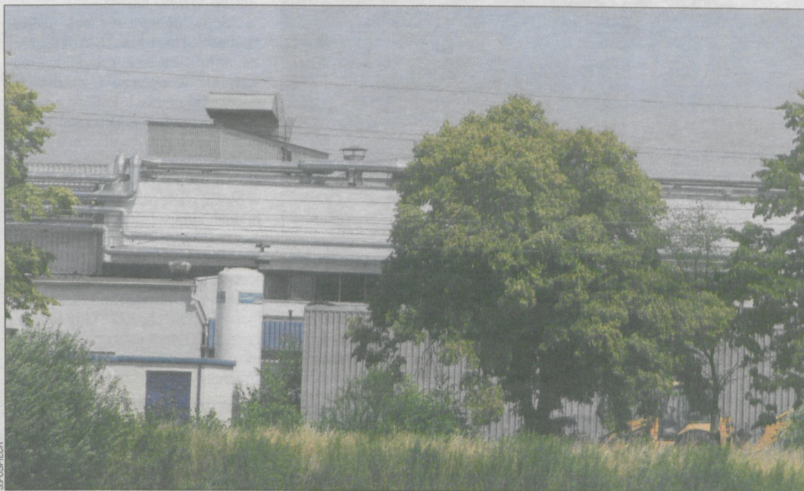
Największy zakład w naszym rejonie od południowej strony
