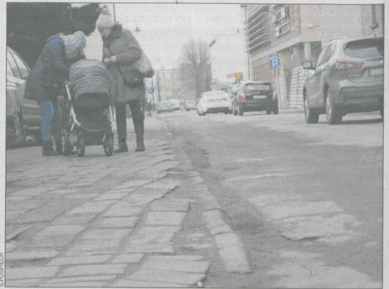
Krzywe chodniki zastąpi kostka brukowa, a na jezdni będzie nowy asfalt
