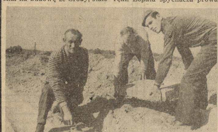
Na zdjęciu: majster Władysław Kowalski (z lewej) i jego brygada; Zdzisław Wiecek i Zdzisław Sobczak przy budowie kanalizacji odwadniającej drogę. Fot. — K. Przychodzki
