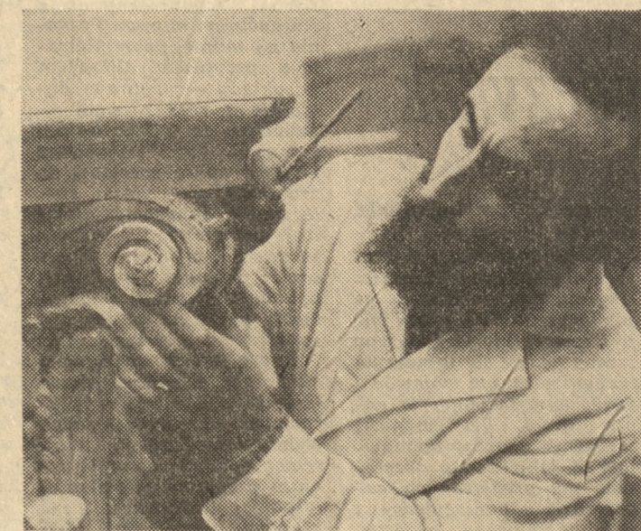
Na zdjęciu: konserwator Henryk Tomoń uzupełnia zniszczone detale głów wieńczących dawniej kolumny w kaplicy Zamku Królewskiego w Warszawie.
